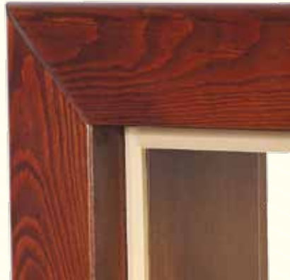
ŁĄCZENIE POD KĄTEM 45 STOPNI
